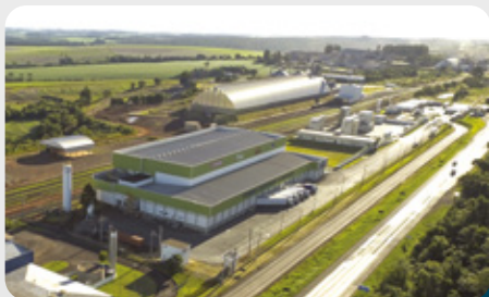
CÂMARA FRIGORÍFICA | CASCAVEL - PR
