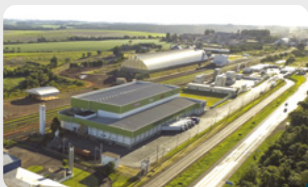
CÂMARA FRIGORÍFICA | CASCAVEL - PR
