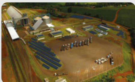
ARMAZÉM GRANELEIRO | CASCAVEL - PR
